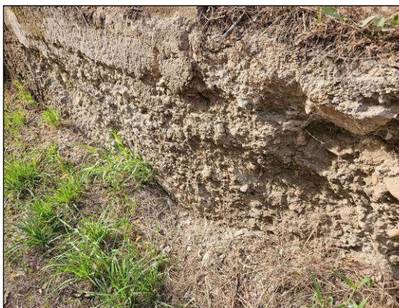
Slika 6 Potporni zid (ograda) – Betonska nearmirana greda. Oštećenja u vidu erozije betona usled abrazije, dejstvo mraza i soli, poprečne pukotine, odvaljivanje delova betona.
