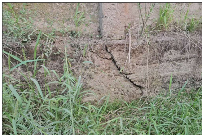
Slika 6 Potporni zid (ograda) – Betonska nearmirana greda. Oštećenja u vidu erozije betona usled abrazije, dejstvo mraza i soli, poprečne pukotine, odvaljivanje delova betona.
