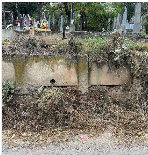
Slika 3 Potporni zid (ograda) – Erozija i spiranje tla u zoni temelja.
