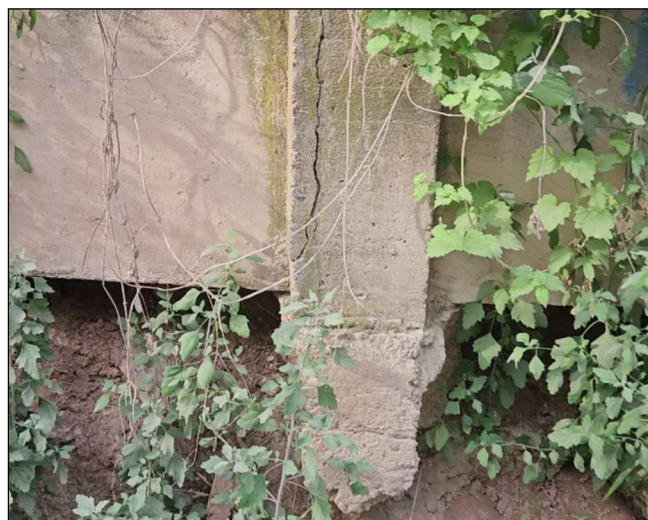
Slika 7 Potporni zid (ograda) – Podužna pukotina na stubu ograde na mestu žljeba.
