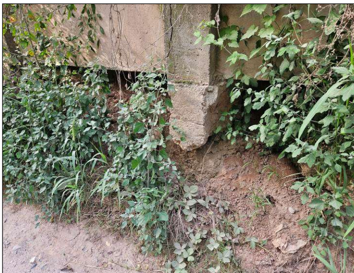
Slika 3 Potporni zid (ograda) – Erozija i spiranje tla u zoni temelja.
