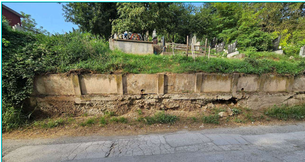
Slika 1 Potporni zid (ograda) – Pogled (leva strana puta)
