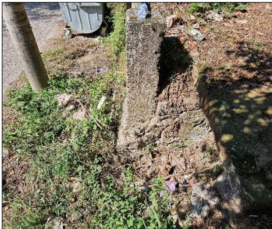
Slika 8 Šaht propusta – Van funkcije.
