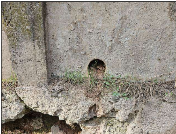
Slika 4 Potporni zid (ograda) – Barbakane prečnika 15 cm. Ispiranje tla iza kosine kroz barbakane, rastinje u barbakanama.
