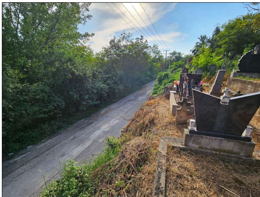
Slika 5 Potporni zid (ograda) – Širi prikaz predmetne kosine groblja, potpornog zida i saobraćajnice, smer Skorica-Plana.
