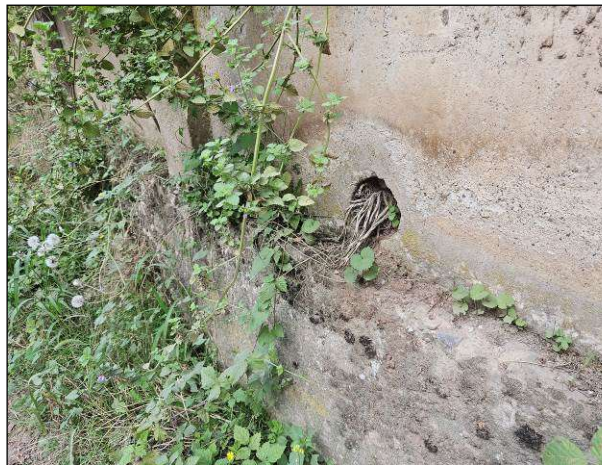
Slika 4 Potporni zid (ograda) – Barbakane prečnika 15 cm. Ispiranje tla iza kosine kroz barbakane, rastinje u barbakanama.
